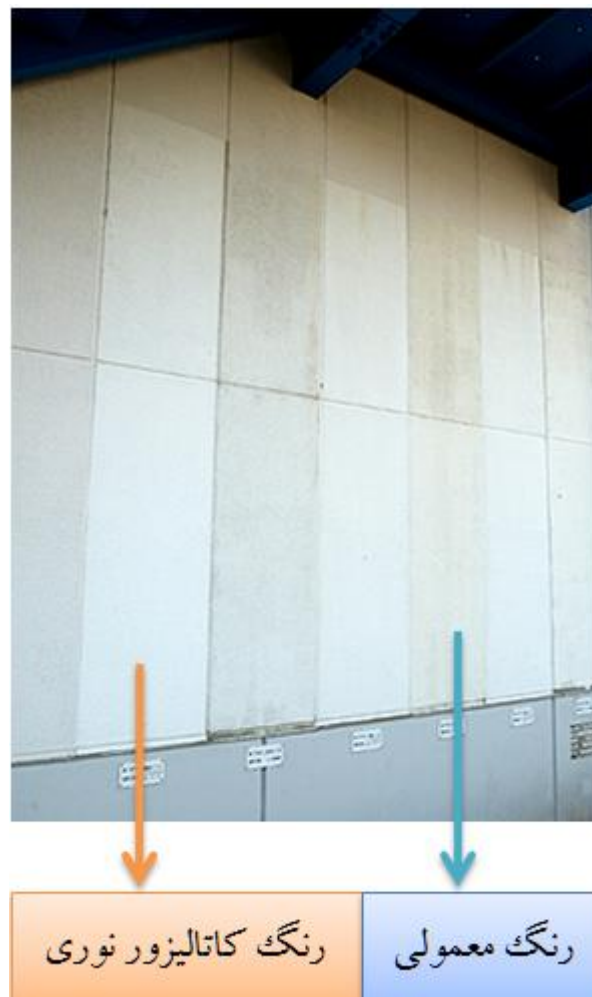
شکل ۷- دیوار رنگ شده به تناوب توسط رنگ معمولی و رنگ کاتالیزور نوری
